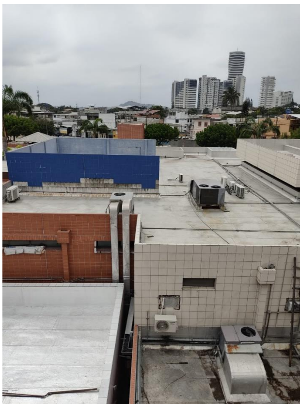
Figura 1 Cubierta del edificio.
