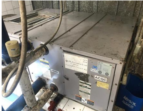
Figura 2.7. UMA quirófano en subsuelo con toma de aire fresco [Elaboración propia]
