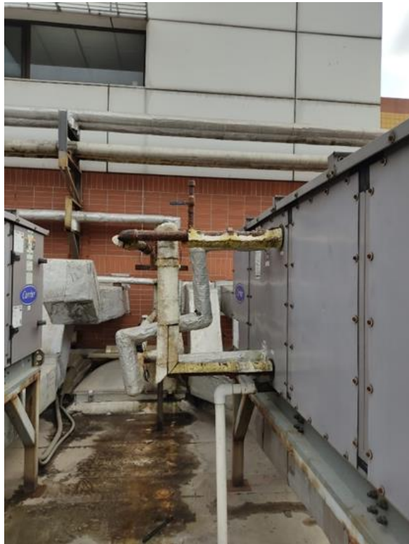
Figura 2.5. Manejadoras adaptadas para suplir demanda [Elaboración propia]
