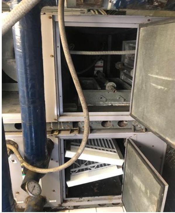
Figura 2.5. Manejadoras adaptadas para suplir demanda [Elaboración propia]
