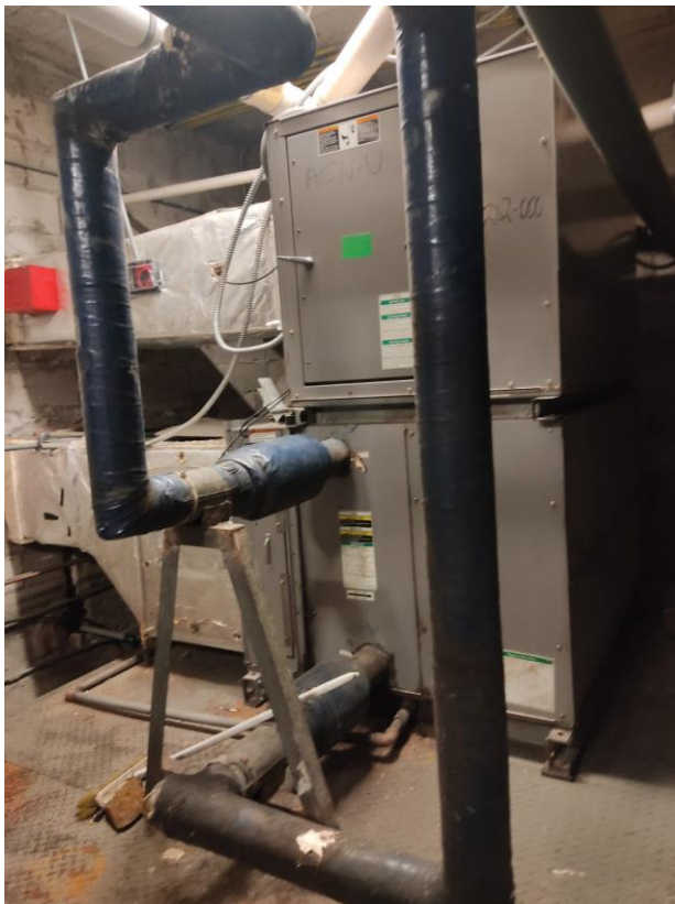
Figura 5 Manejadora en mezanine, climatiza cafetería.
