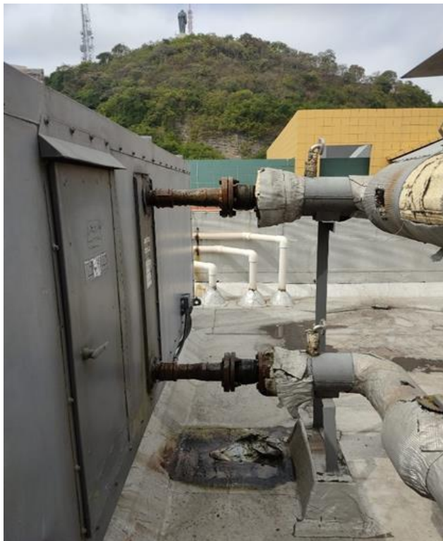
Figura 2.3. Serpentines de agua caliente (No operativos) [Elaboración propia]
