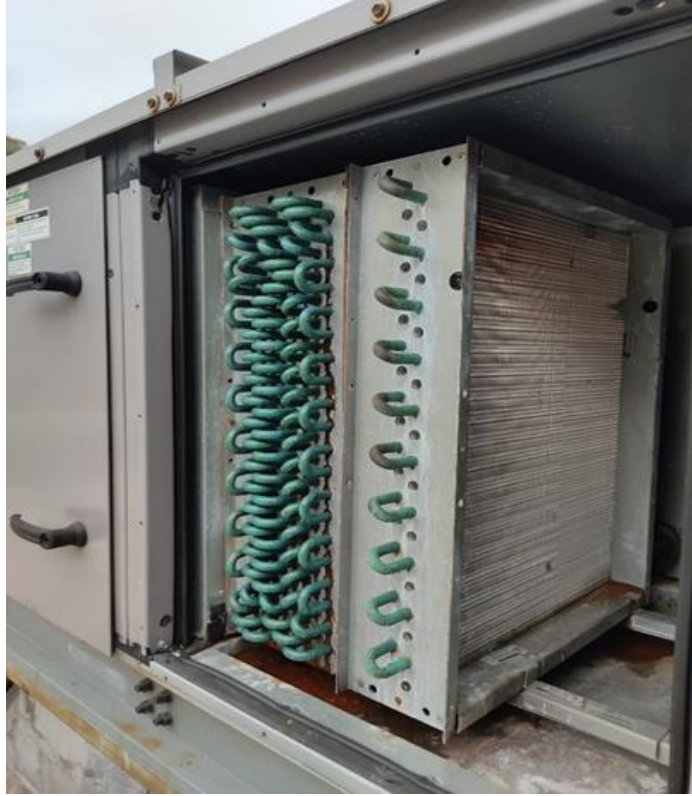
Figura 2.3. Serpentines de agua caliente (No operativos) [Elaboración propia]
