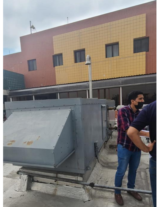
Figura 8. Conversación con técnicos sobre estado de equipos
