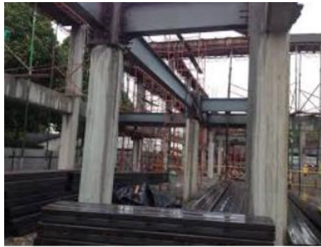
Figura 2.10 Pórticos de estructura mixta
