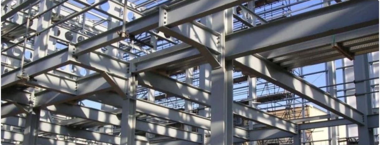
Figura 2.8 Pórticos de acero con elementos W
