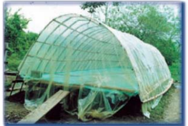
Secador tipo túnel
