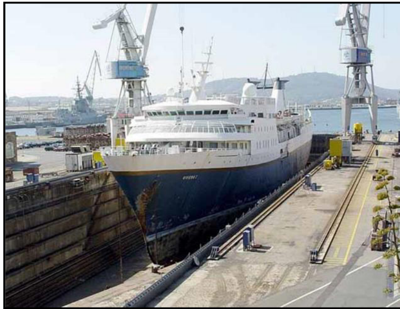
Figura 1. 1. Dique Seco de El Ferrol
