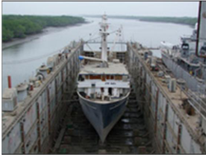
Figura 1. 2. Dique Flotante Río Orellana
