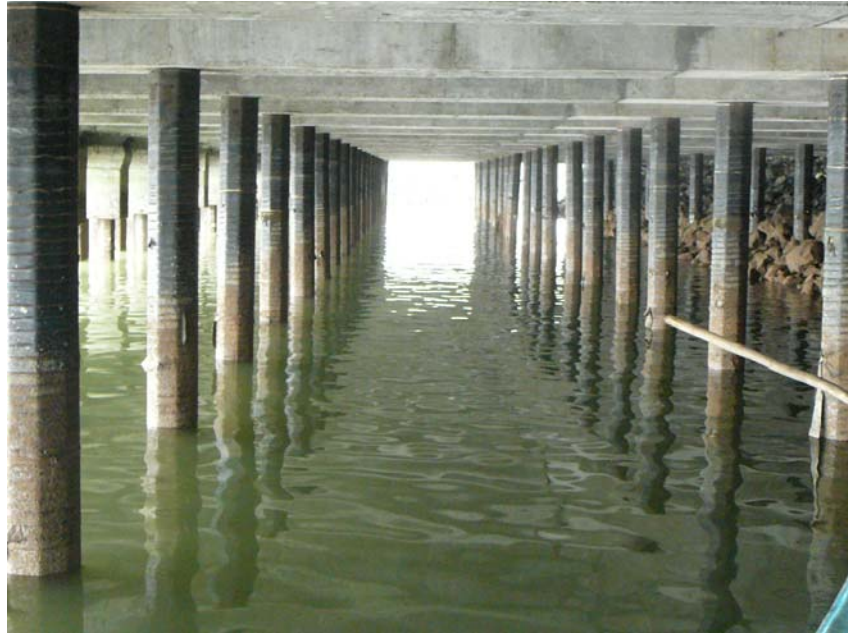
FIGURA 2.5: PILOTES RECUBIERTOS MEDIANTE TAPE A BASE DE PETROLATUM
