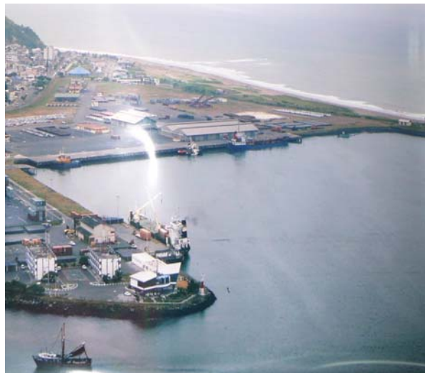
FIGURA 2.2: VISTA PANORÁMICA DE LOS MUELLES
