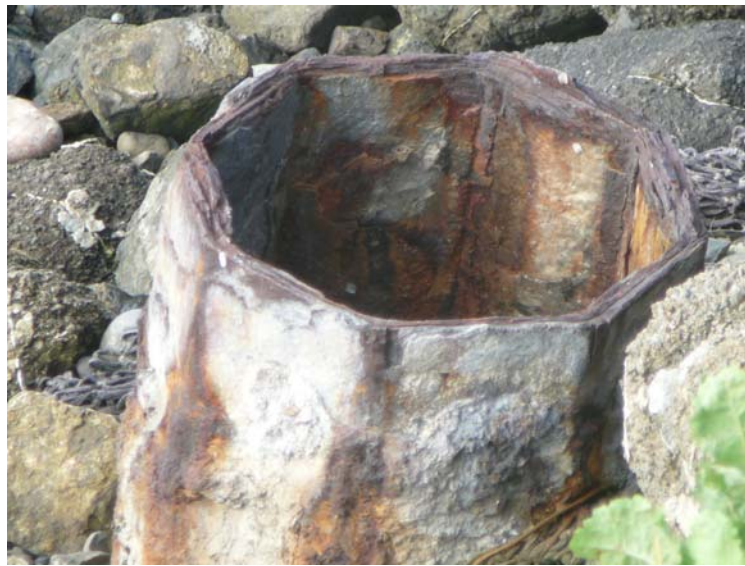
FIGURA 2.3: PILOTE FRODINGHAM No. 4 DE 8 LADOS ENTERRADOS EN LA COSTA DEL MUELLE
