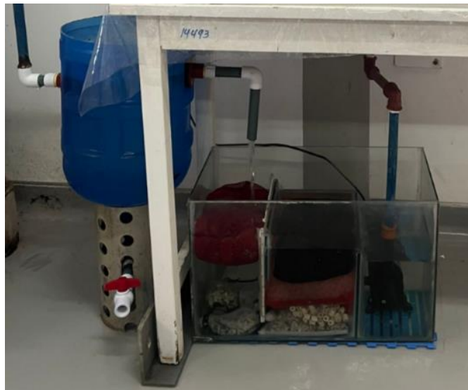
Figura 2.3 Ejecución del Sistema de decantación.
