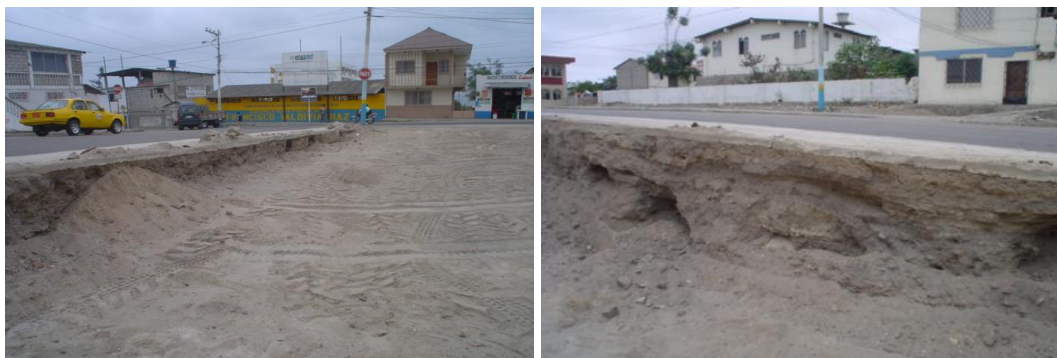
Figura 42.4. Detalle de perfiles de corte en la terraza habitacional de la esquina de la 2da avenida y calle 23, en el solar esquinero se levanta hoy en día el edificio Coechir. Vista al oeste y SO respectivamente.
