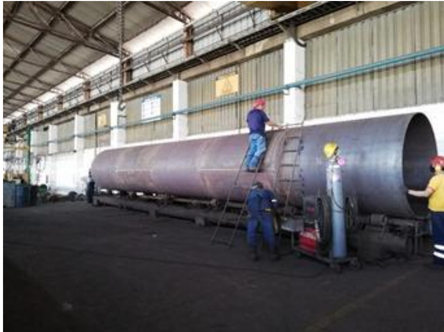
Figura 1.4 Armado de tubo [Elaboración propia]
