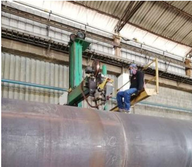
Figura 1.5 Soldadura circunferencial del tubo [Elaboración propia]
