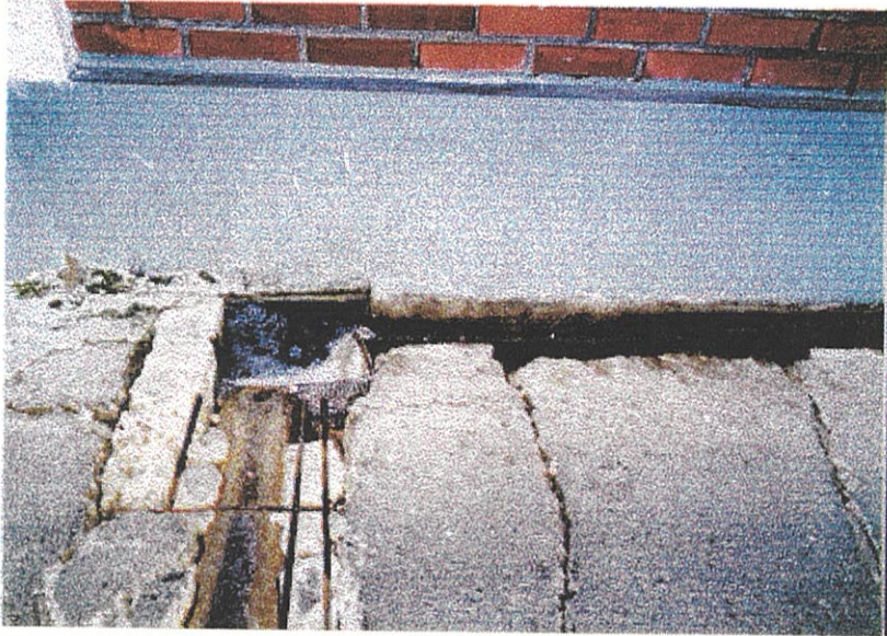
Figura # 3.- Canal del efluente de una empacadora.
