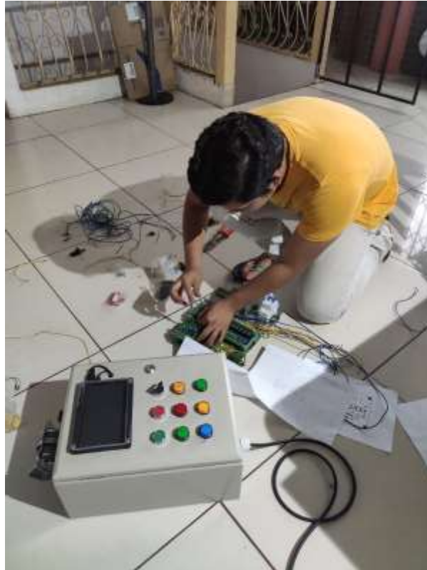
Foto 9 Armado de tablero de control.
