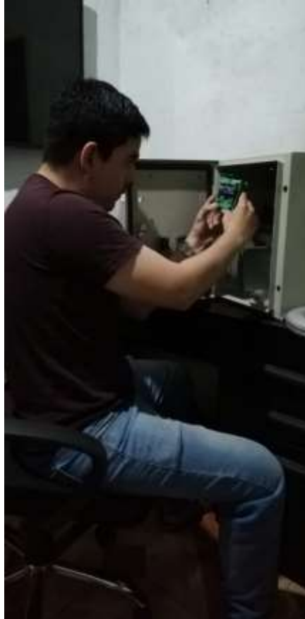
Foto 5 Colocación de equipos en Riel Din.
