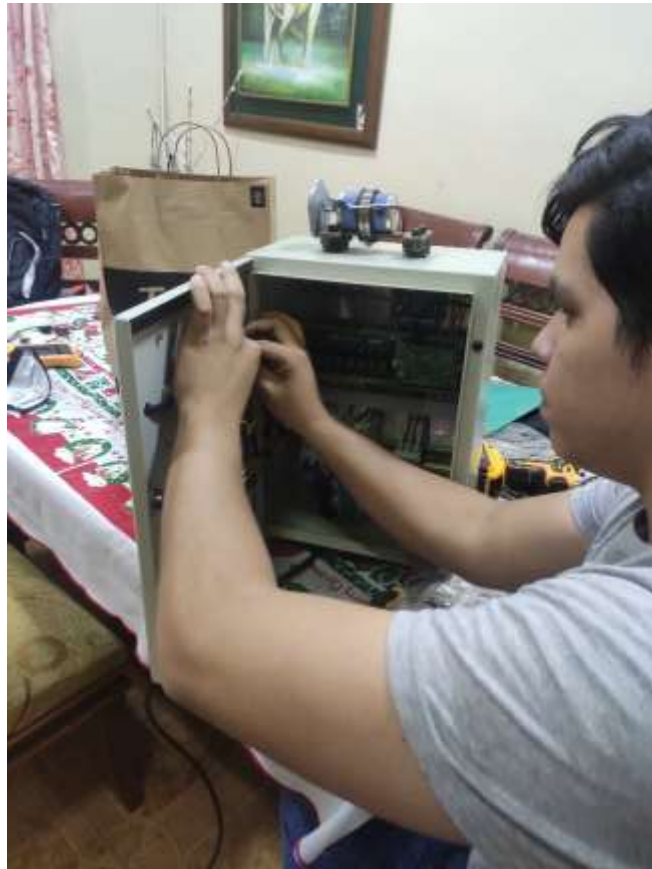
Foto 8 Ajuste de cableado.
