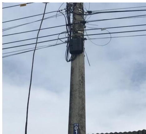
Figura 2.2.2 Caja NAP de fibra óptica
