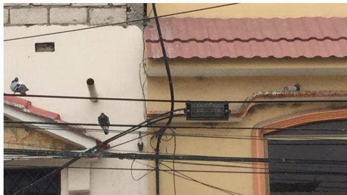
Figura 2.2.1 Manga fibra óptica tipo rectangular
