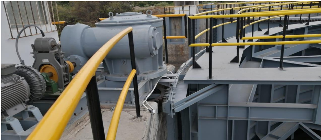
Figura 2.6 Caja reductora esclusa de Guayaquil
