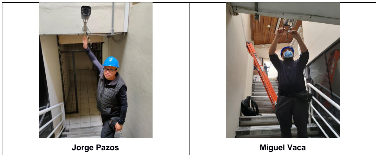
Figura 3.12 Instalación de cámara en nodo piloto.
