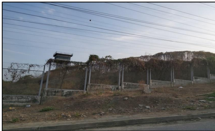
Figura 3.13 Costado sur con elevación de terreno.
