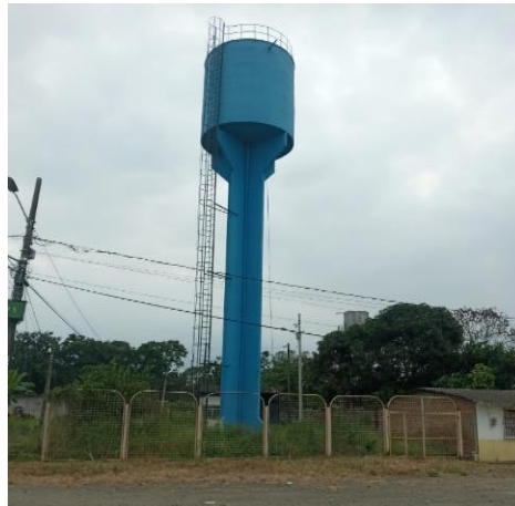
Figura 2.1. Terreno, pozo y tanque de la comuna
