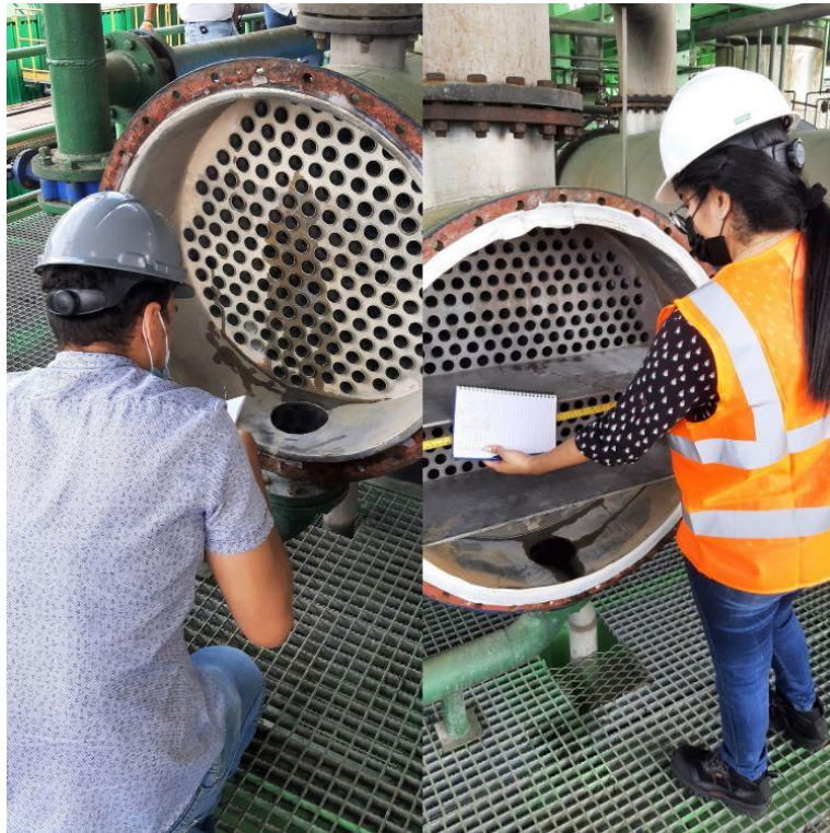
Figura 2.2 Medición de las dimensiones de condensadores
