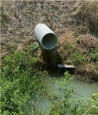
Figura 4.5. Compuerta de salida de piscinas camaroneras en el Sector Seis de Julio.
