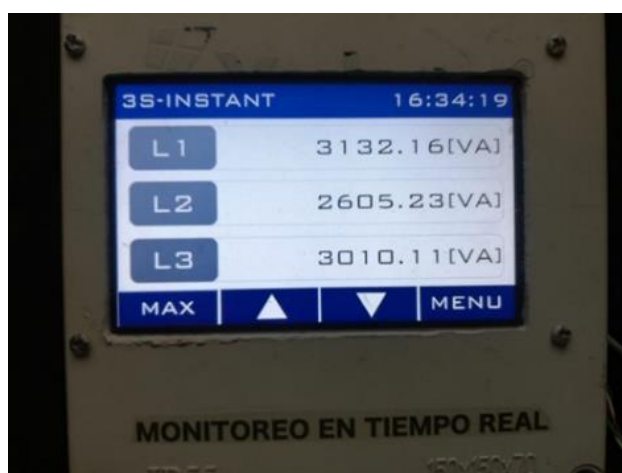
Figura 3.18 Monitoreo de la potencia aparente instantánea de cada fase.
