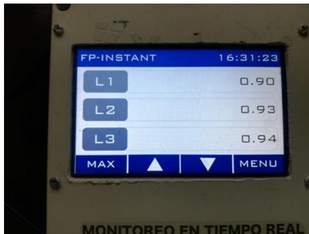
Figura 3.19 Monitoreo del factor de potencia instantáneo de cada fase.
