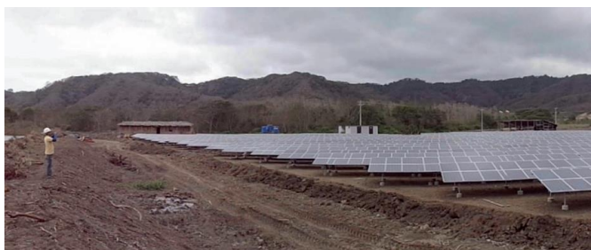
Figura 2.2 Vista de la Planta fotovoltaica Brineforcorp [41].
