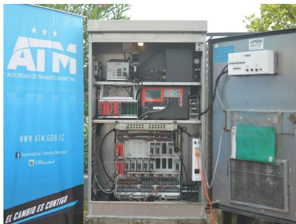
Figura 2.2 Armario semafórico de la ATM
