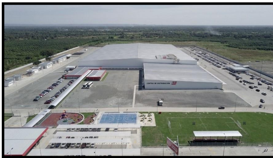
Figura 1.1 Centro de distribución nacional
