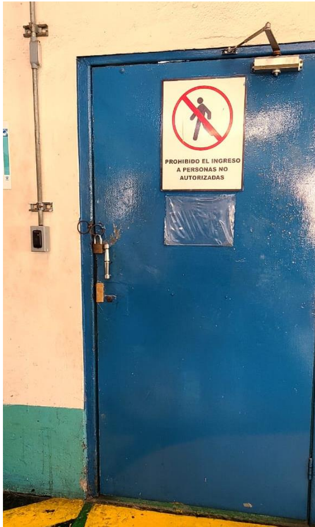
Figura 1.2 Estado actual del ingreso a la bodega con lector RFID.
