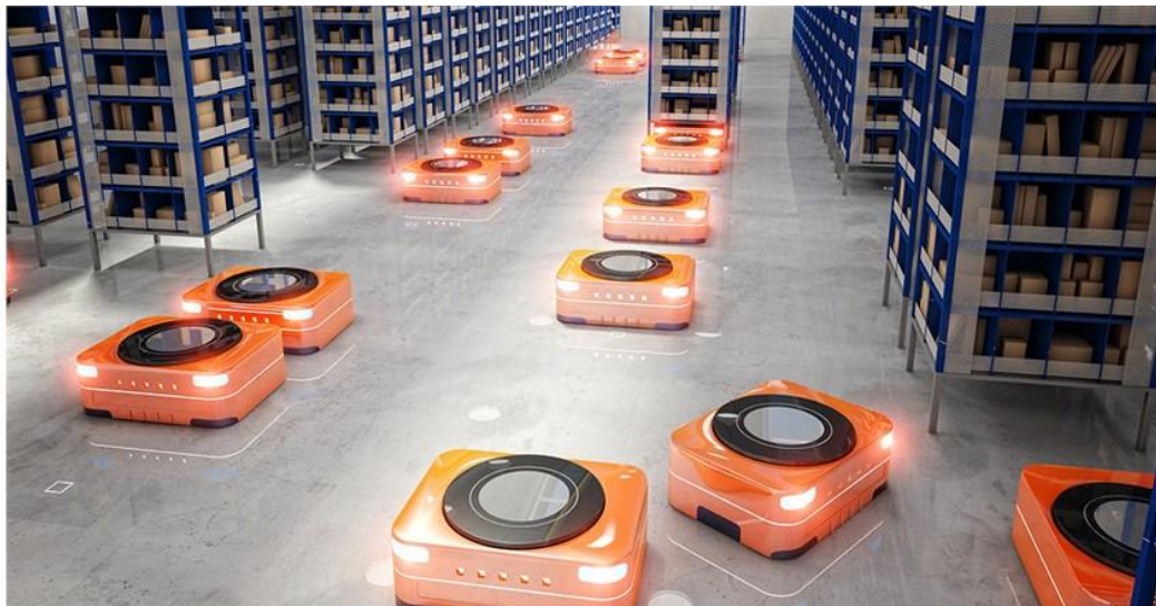
Figura 1.9 Control de bodega con robots controlados vía red internet
