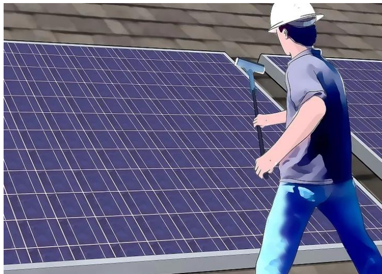
Figura A16. Limpieza de paneles solares
