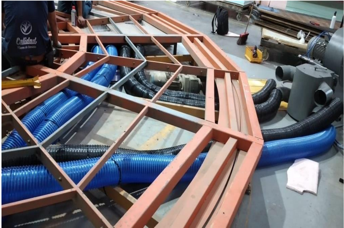
Figura 0.7 Conexión con Ductos. [Abril Pachacama]
