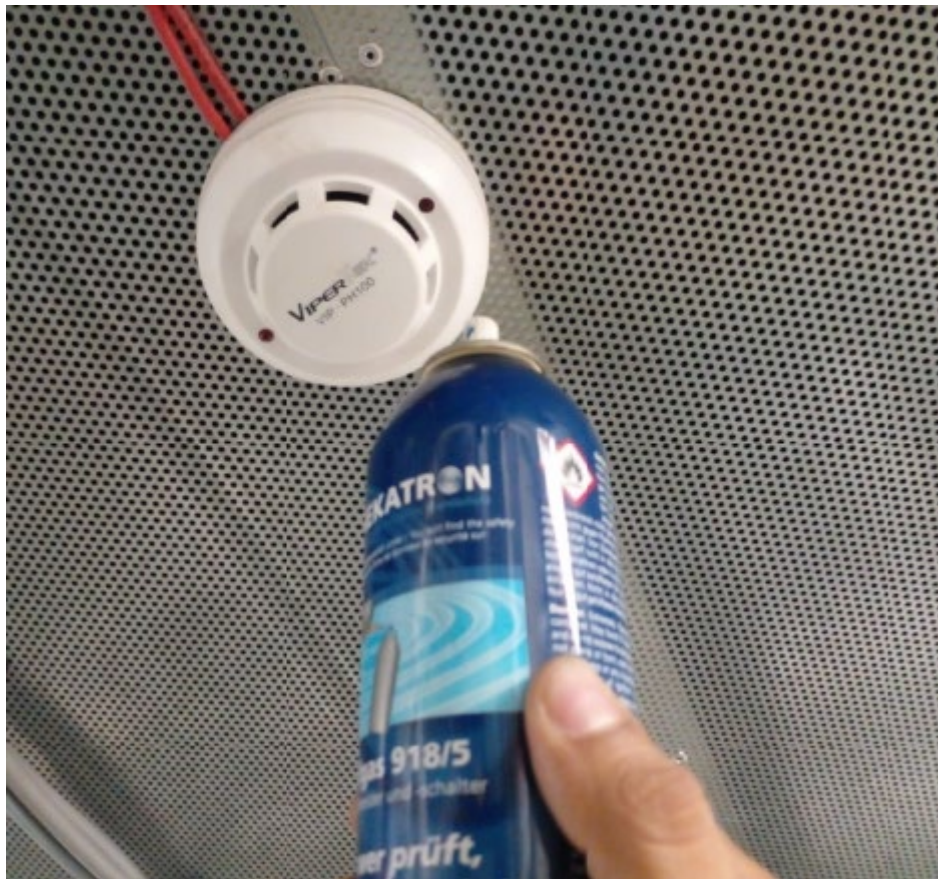
Figura 3.16 Prueba para activar la señal de detección de humo en Grúa Gottwald #2
