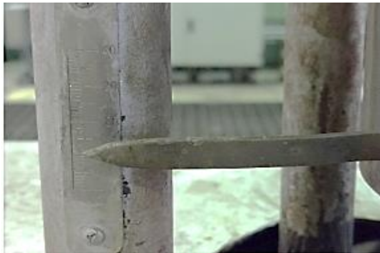
Figura 2.2: Aguja indicadora de posición de las válvulas (Rodriguez, 2021, pág. 20)
