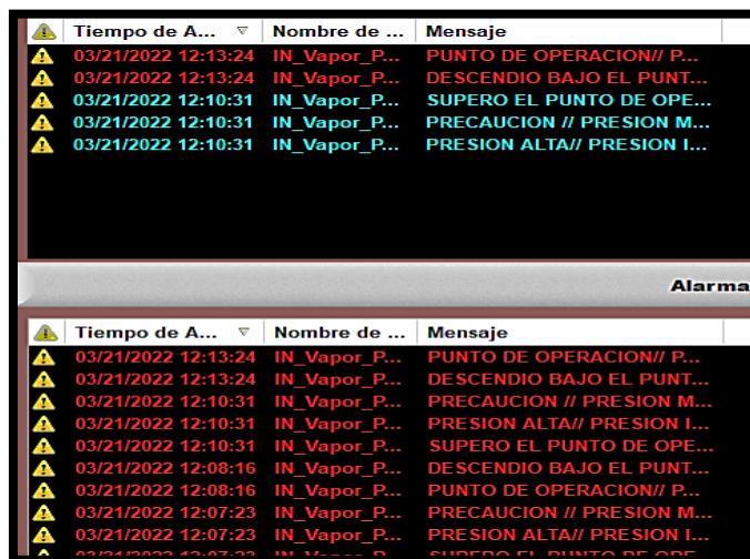
Figura 2.42 Ventana de alarmas
