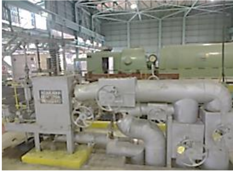
Figura 2.1: Regulador de vapor de sellos de empresa generadora de electricidad (Rodriguez, 2021, pág. 20)
