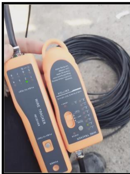
Ilustración 18 Prueba de funcionamiento del cableado
