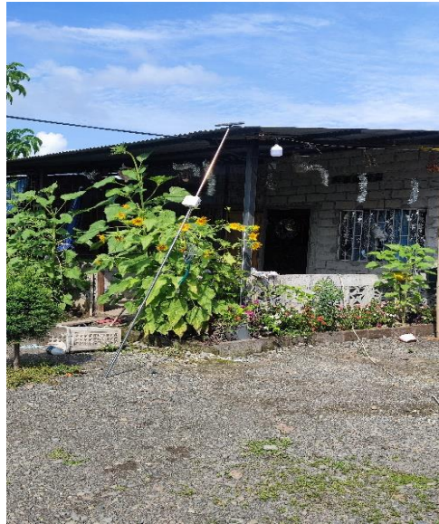
Ilustración 4.3 Nodo 2 antes de su instalación
