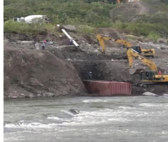
Fotografía 6. Trabajos de reforzamiento de contenedores y construcción de acceso al río. Fuente: CELEC EP
