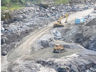
Fotografía 5. Construcción de dique conformado por contenedores. Fuente: CELEC EP
