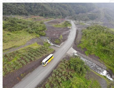
Fotografía 4. Variante provisional de 650 metros en el km. 67.5 habilitada al paso vehicular sin restricciones desde el pasado mes de junio.
