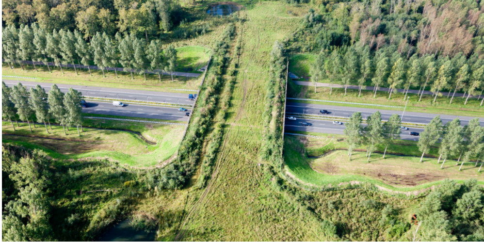
Figura 4.1: Puente peatonal para animales
