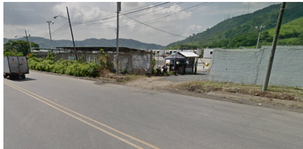
Figura 2.3: Datacenter de la empresa Telconet
