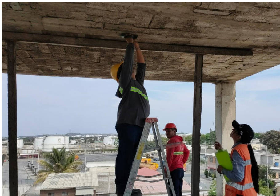
Ilustración 2.5 Ensayo de detección de armadura en sitio del proyecto
