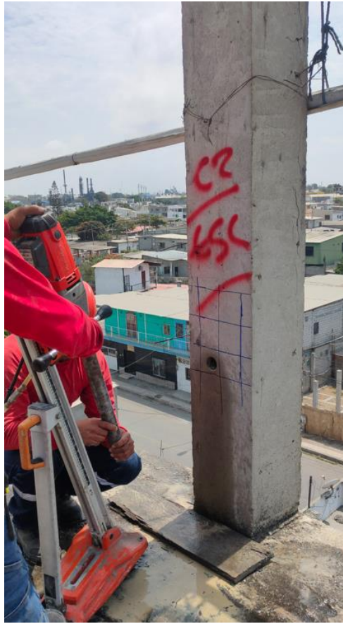
Ilustración 2.4 Extracción de núcleos a ensayar en proyecto
