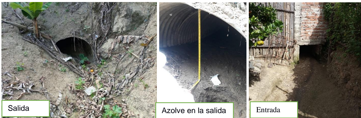
Figura 3.25 Entrada y salida de la alcantarilla actual
