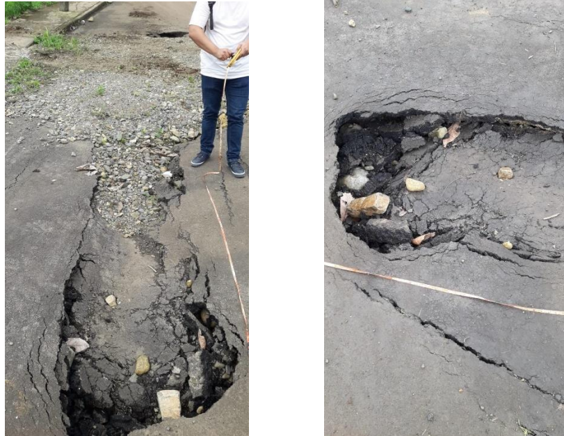
Ilustración 16. Hundimientos graves. Fuente: Elaboración propia
