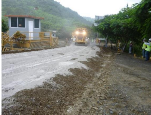
Ilustración 19. Uso de bases granulares estabilizadas con cemento
