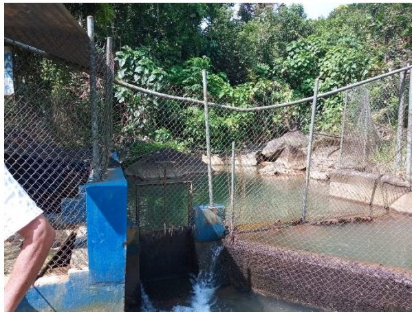
Figura 1.2 Estructura de captación actual
