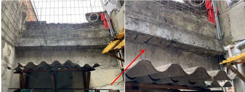
Figura 1.5 Viga al lado derecho del patio
