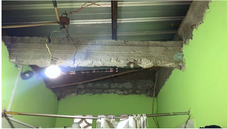
Figura 1.22 Vigas al interior de la vivienda del lado donde se encuentra ubicado el tanque elevado.
