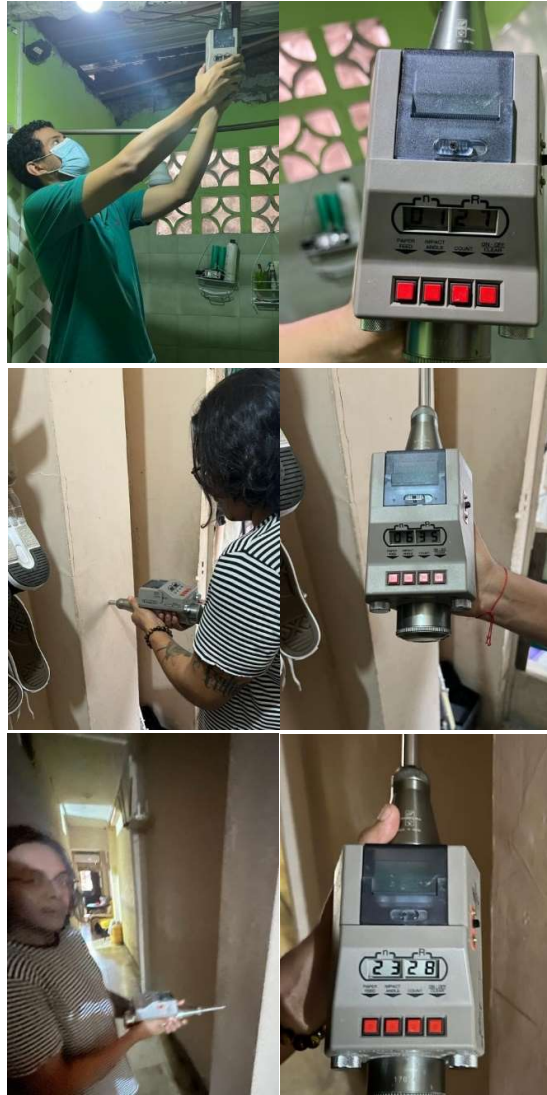
Figura 3.1 Ensayo de esclerometría
