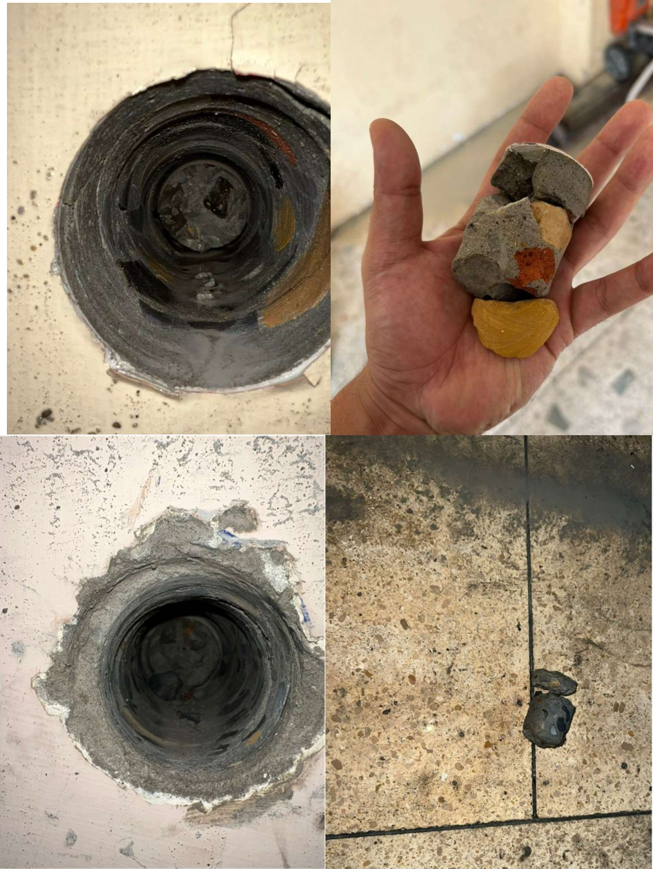
Figura 3.3 Extracción de Núcleos de la Vivienda
