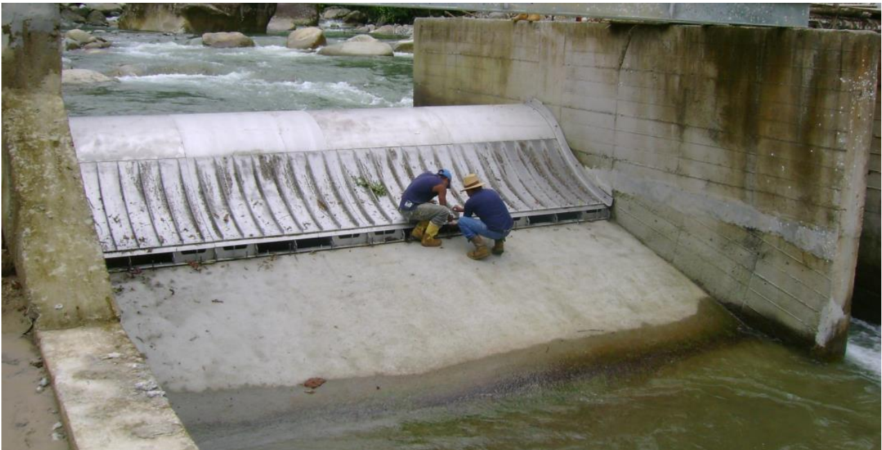
Figura 2.5 Instalación de Azud en Rio. [Ramiro & Erazo, 2017]
