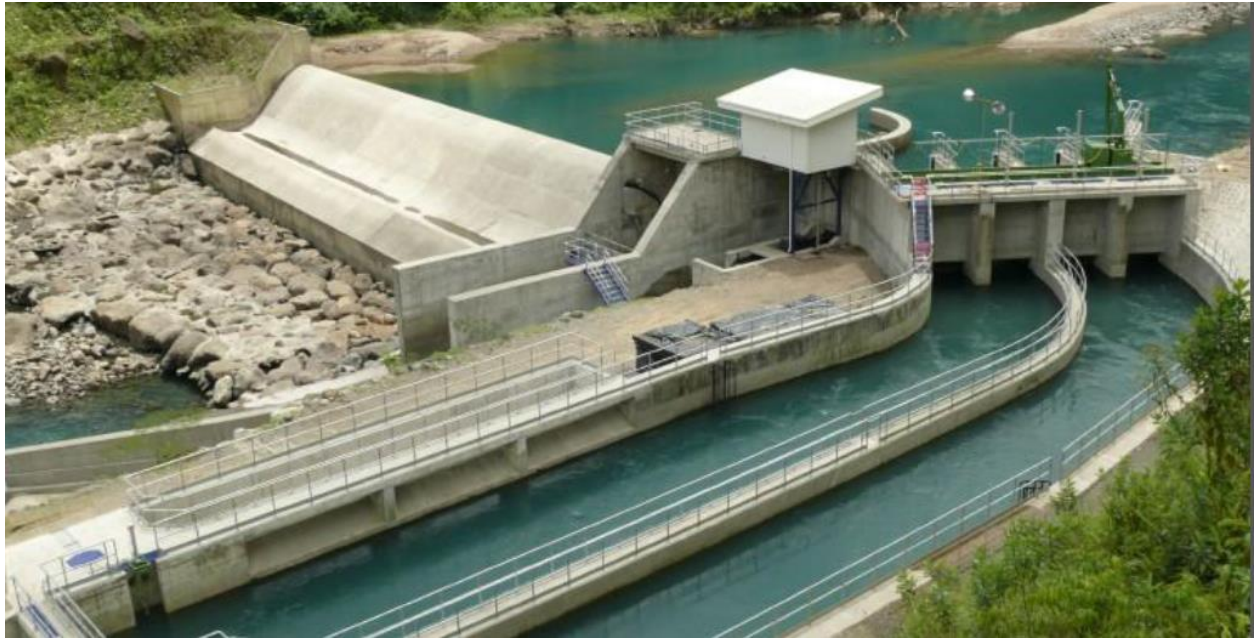
Figura 2.2 Captación lateral en un río. [Ramiro & Erazo, 2017]
