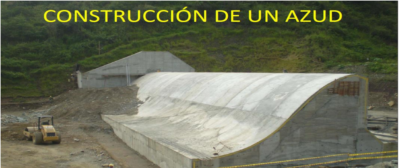
Figura 2.4 Ejemplo de construcción de Azud. [Ramiro & Erazo, 2017]
