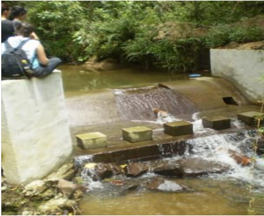
Figura 1.4 Obra de toma tipo dique
