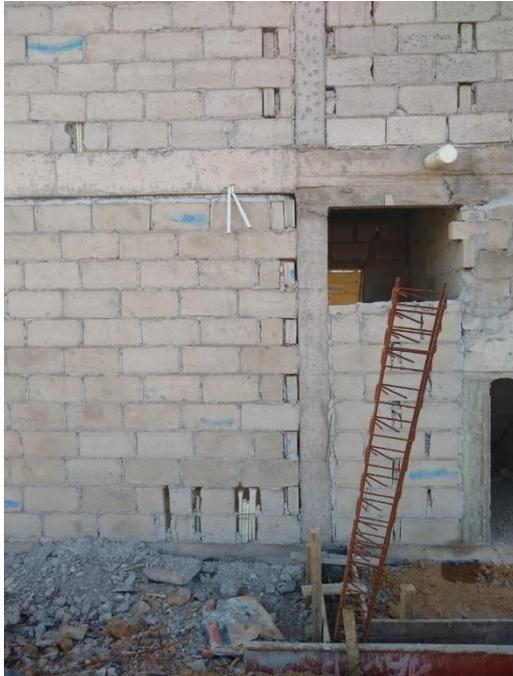
**Figura 2.16 Tubería para circuito tomacorrientes**
