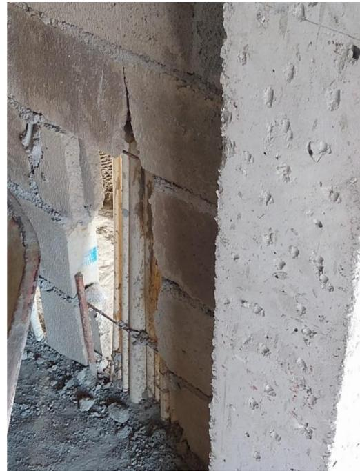
**Figura 2.18 Tubería para circuito de tomacorrientes**
