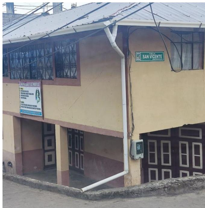
**Figura 2.9 Bajante de aguas lluvias**
