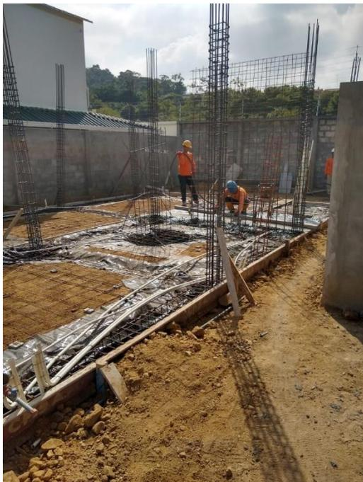
**Figura 2.13 Tubería flexible por losa**
