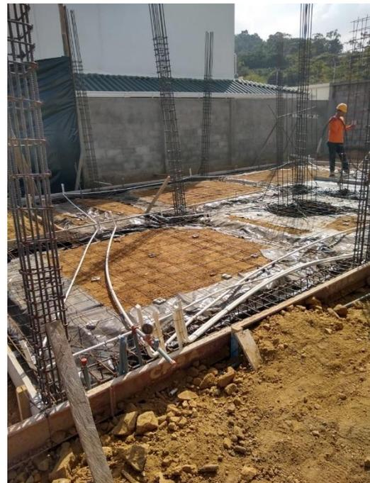
**Figura 2.14 Tubería flexible por losa**
