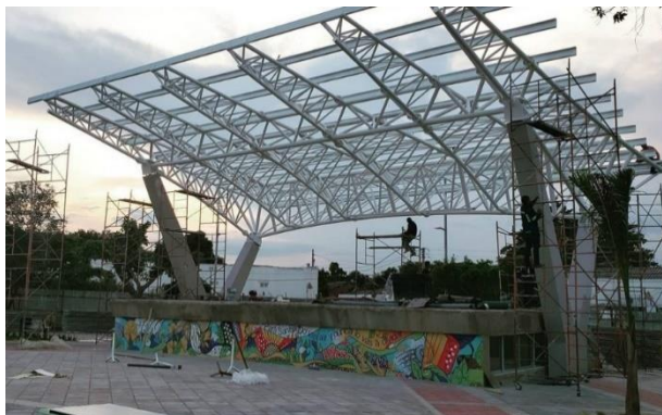
Figura 2.2: Estructura de acero (Conceptos de ingeniería,2022)
