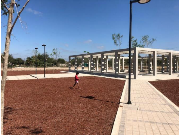
Figura 2.1: Estructura de hormigón armado (MImexicolate,2020)
