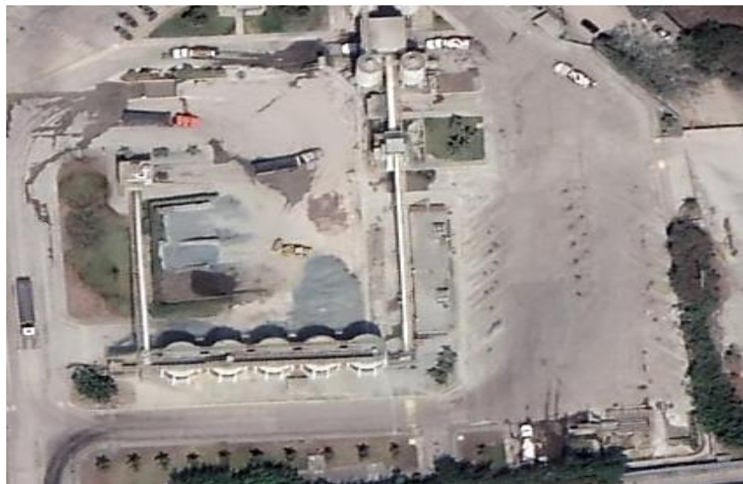
Figura 31. Vista Aérea de Instalaciones de Hormigonera. Fuente: Google Earth
