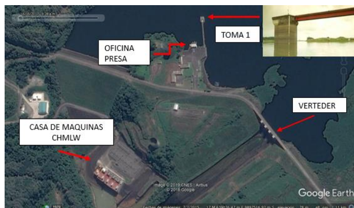
Figura 1.- Ubicación de Presa Daule Peripa en Proyecto "Jaime Roldós Aguilera".
