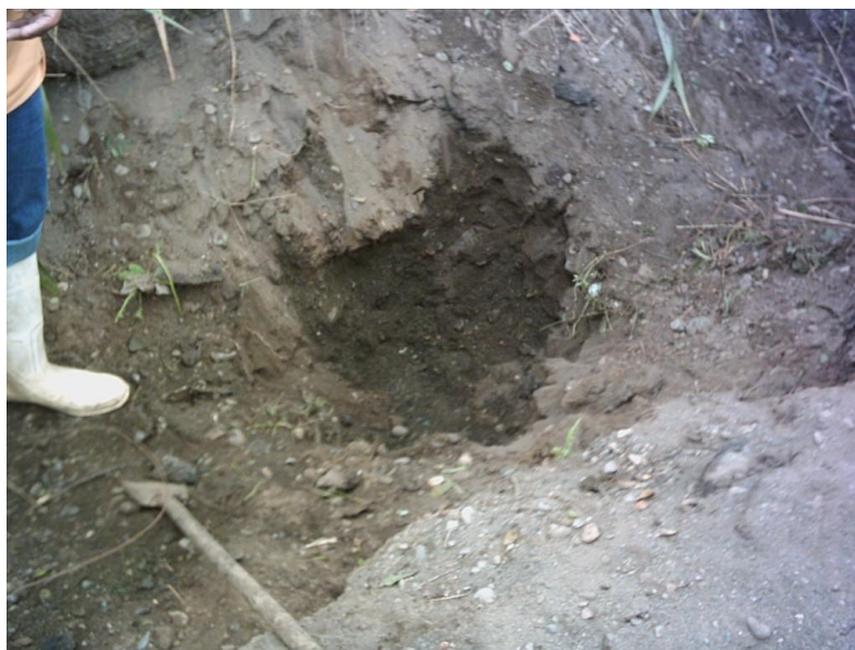
Fotografía N. 1, excavación de la calicata uno en la cabecera del nuevo botadero. Tipo de material arena con grava
