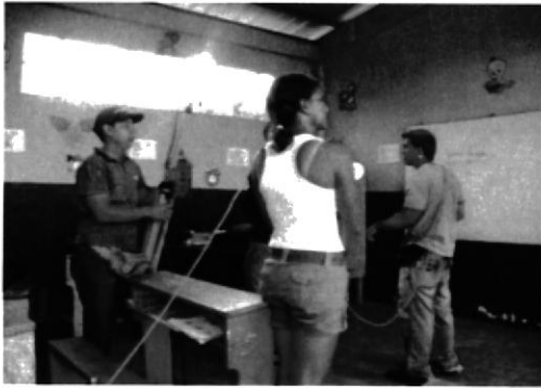
Fig. 10-54 Prueba de iluminación
