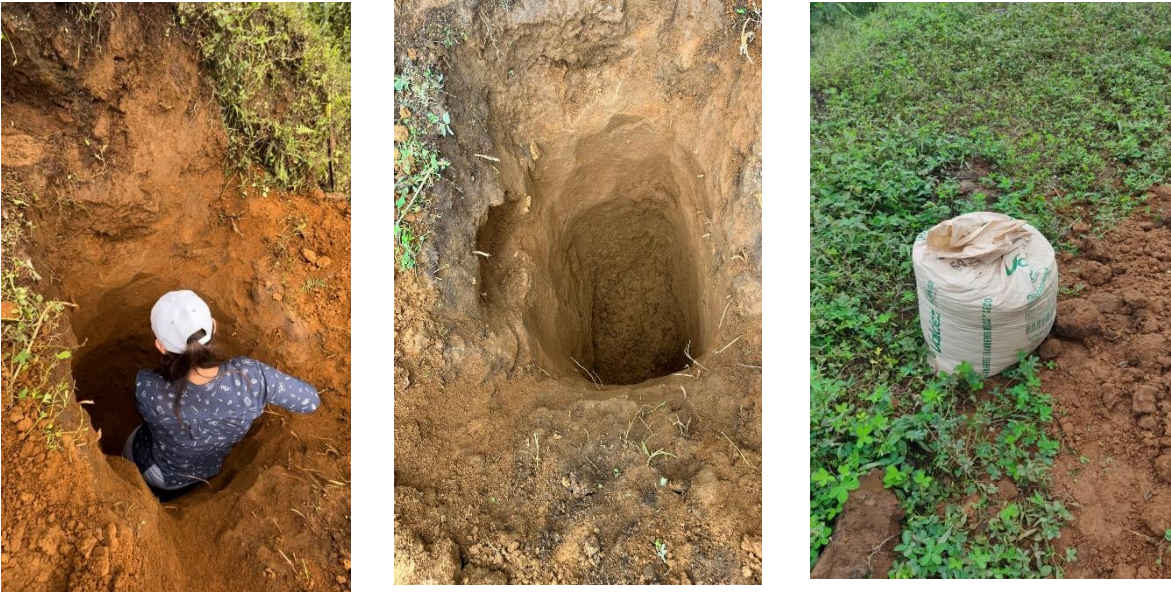
Figura 2.7 Calicata a los 3.3 km de longitud. [Castro & Fajardo, 2023]
