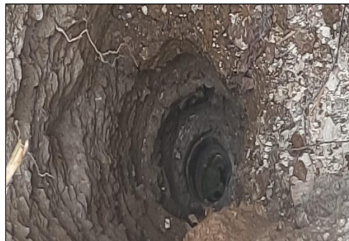
Figura 3.5 Perforación a 2 metros. Fuente: Eva Chacón y Brayan Pinto
