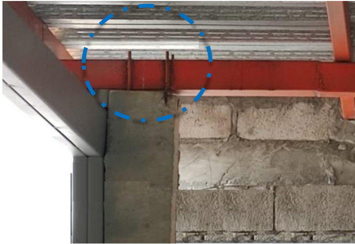
Figura 3.24 Columna principal A1 segundo piso no finalizada.
