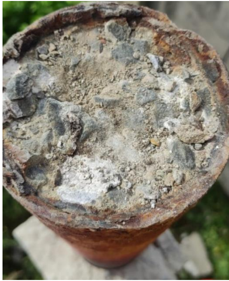
Figura 3.19 tubería de petróleo rellena con mortero estructural mal dosificado. Fuente: Eva Chacón y Brayan Pinto
