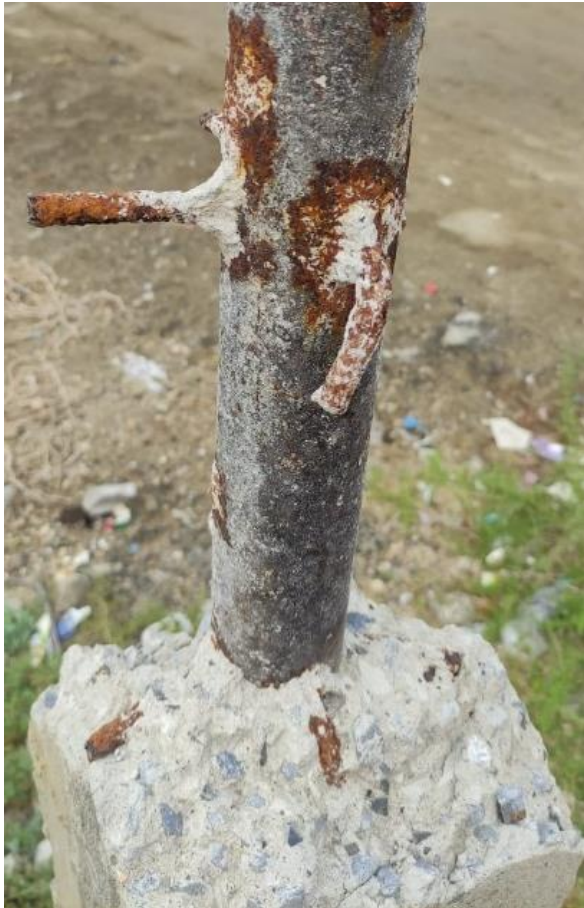
Figura 3.23 Varilla soldada a la tubería de petróleo.
