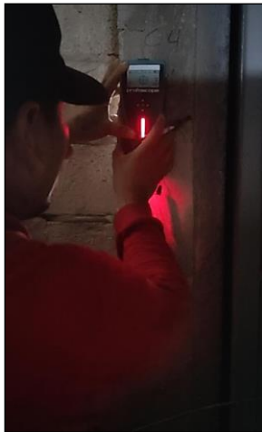
Figura 3.10 Detección de varillas verticales. Fuente: Eva Chacón y Brayan Pinto
