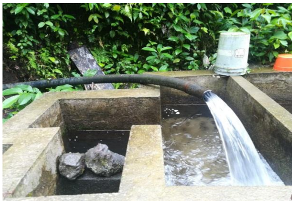
Figura 2.10 Mangueras improvisadas para la captación de agua [GAD Gonzalo Pizarro,2022]
