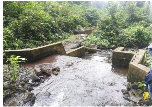
Figura 2.11 Problemas con sedimentos acarreados [GAD Gonzalo Pizarro,2022]
