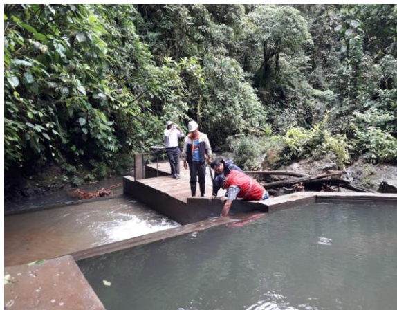
Figura 2.1 Estructura de captación [GAD Gonzalo Pizarro, 2022]
