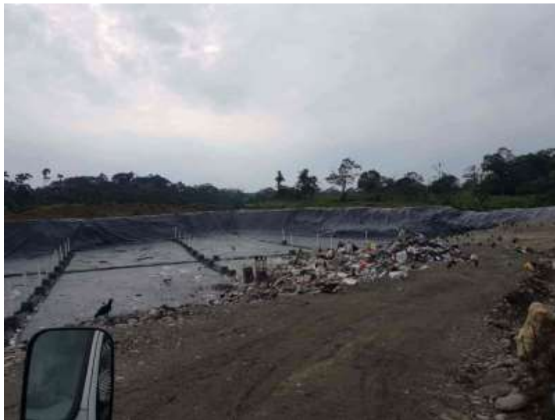
Ilustración 4.5. Relleno sanitario en pésimas condiciones en la provincia de Pastaza
