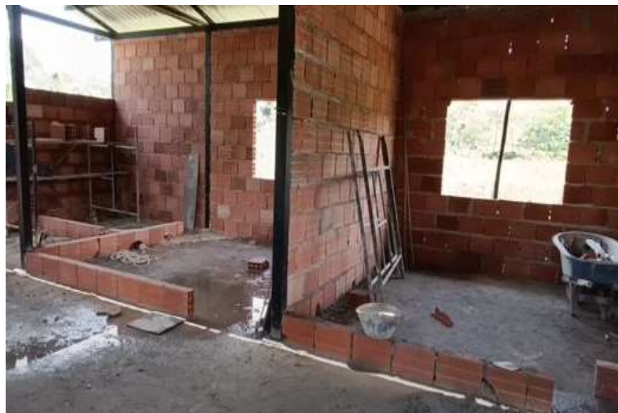
Ilustración 2.30. Muro alternativo 4 en obra. Fuente: (Tutoriales Innovaciones D Y M, 2023)
