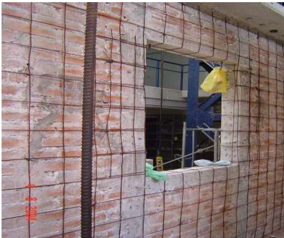
Ilustración 2.24. Muro alternativa 1 en obra. Fuente: (Flores, 2008)
