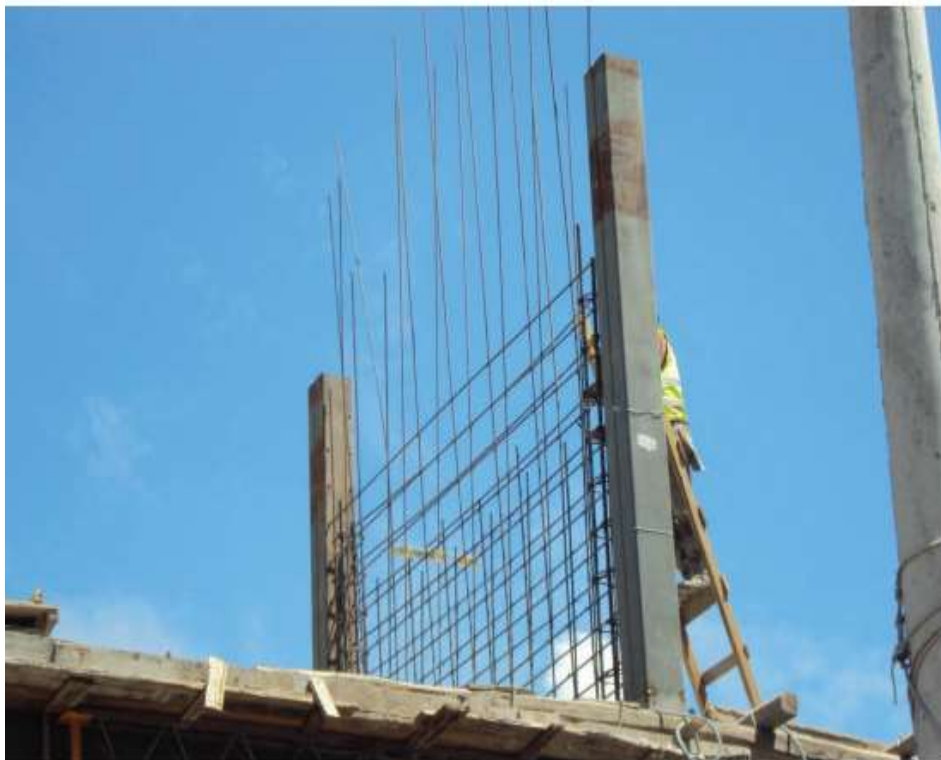
Ilustración 2.28. Muro alternativa 3 en obra. Fuente: (Quishpe, 2015)
