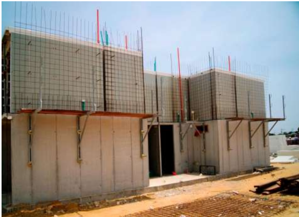
Ilustración 2.26. Muro alternativa 2 en obra. Fuente: (Guerrero, 2019)
