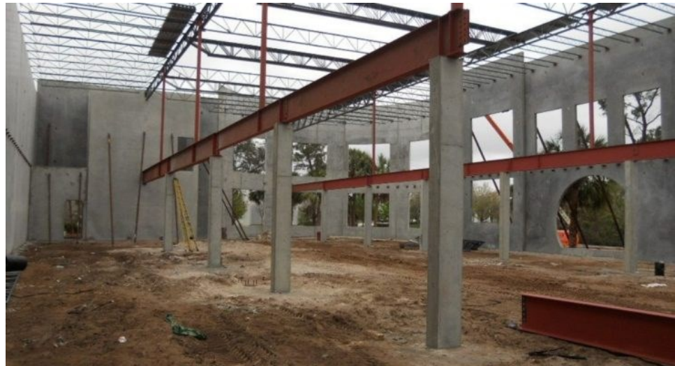
Figura 4. 13 Construcción de una Estructura Mixta [Kathir, 2018]
