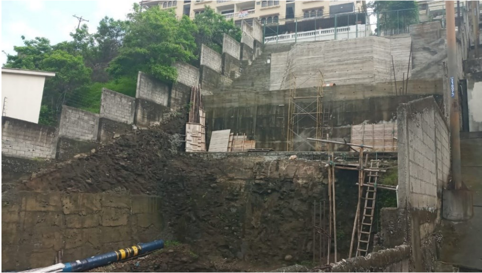
Figura 2. 7 Vista General - Muros de contención del terreno
