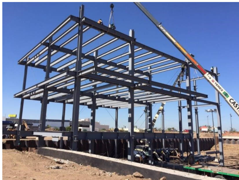
Figura 4. 11 Construcción de una Estructura de Acero [Castilla, 2021]
