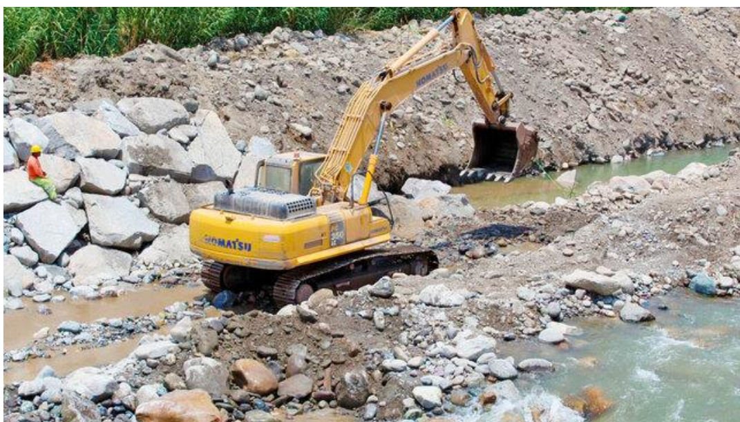
Ilustración 1 - 4. Excavadora trabajando en la construcción de dique enrocado. Imagen obtenida de: Gobernación de Perú.
