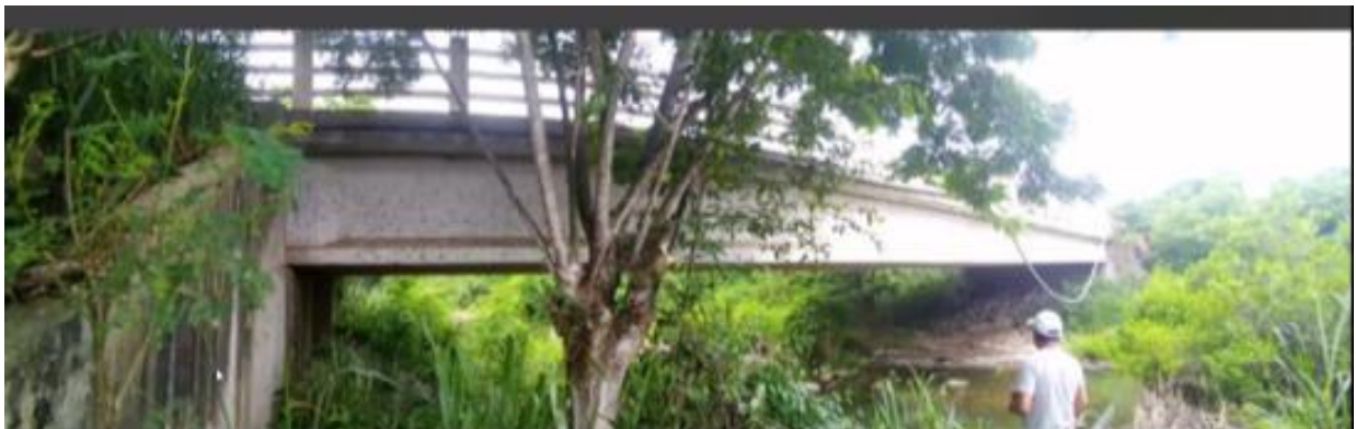
Ilustración 3-5 Puente aguas abajo del rio Manglaralto
