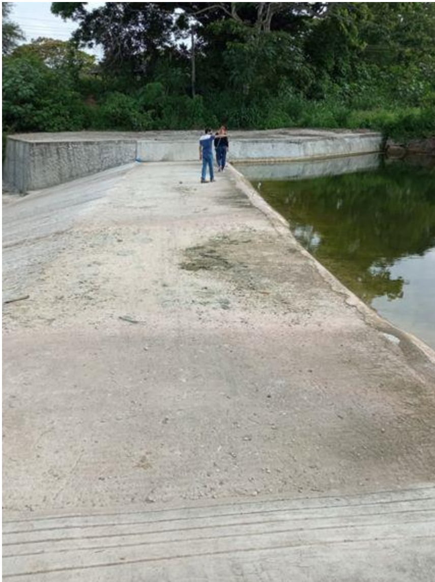
Ilustración 1 - 5. Dique de Manglaralto. Imagen tomada por el autor.
