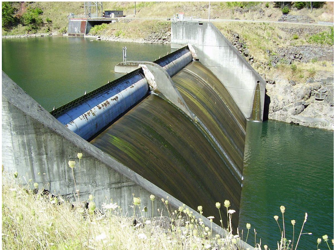
Ilustración 2-1. Caída de agua en un dique.
