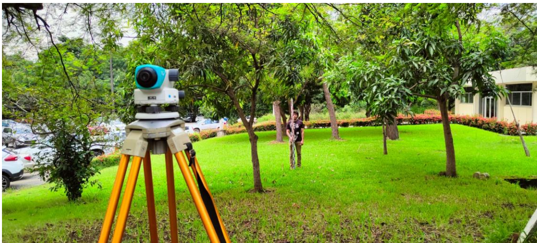
Figura 2.37 Nivelación del terreno
