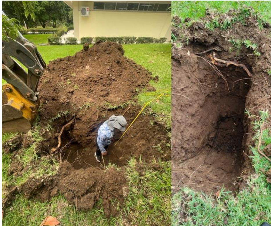
Figura 38 Toma de muestras en calicatas
