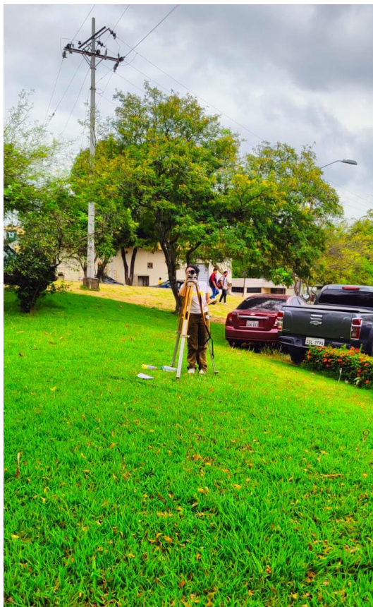
Figura 2.36 Nivelación del terreno
