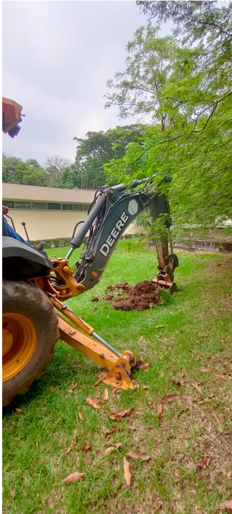
Figura 60 Retroexcavadora realizando calicata
