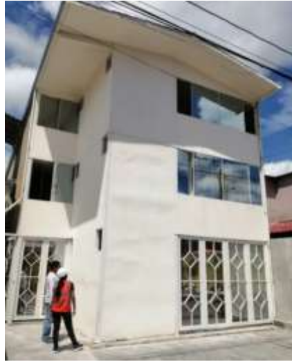
Figura 2.5 Vista fachada frontal - visita al sitio [Martínez & Villamar, 2023]
