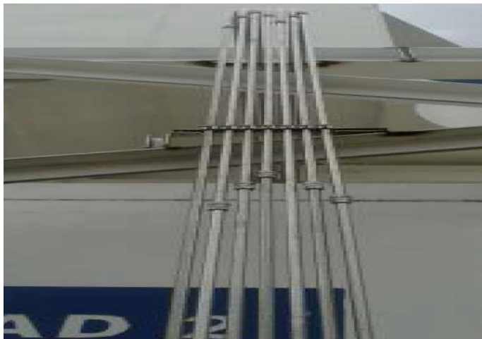
Figura 1.9: Colocación de tubing al manifold de la turbina
