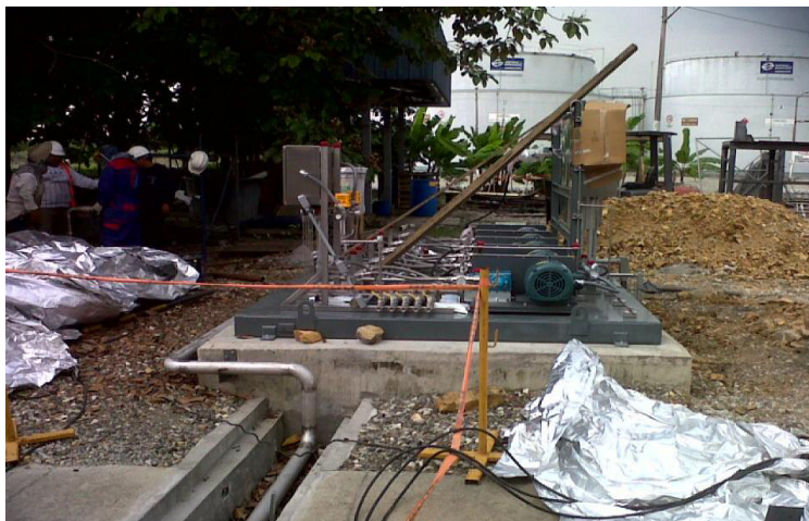
Figura 1.6: Colocación del sistema fogging en la base de hormigón
