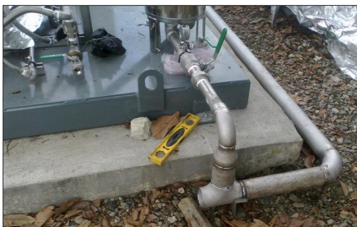
Figura 1.7: Colocación de la tubería de agua de entrada al sistema
